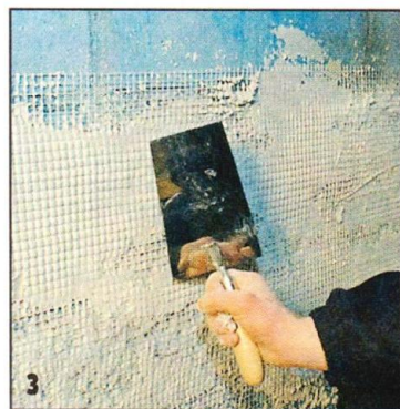
Стыки участков стен, выполненных из разных материалов, необходимо армировать сеткой.
