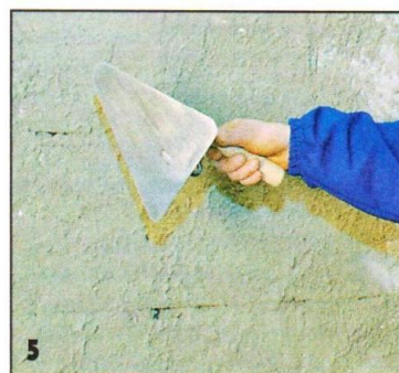
Для обеспечения лучшего сцепления раствора с основой первый слой наносят набрызгом.
