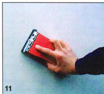
11 После высыхания шпательки неровности (выпуклости) удаляют шлифованием.
