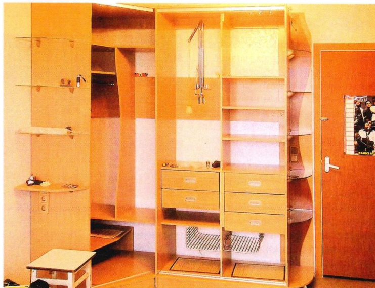
Каркас шкафа установлен, приступаем к его заполнению.
