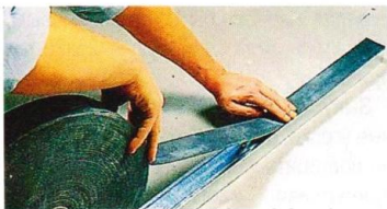
Звукоизоляционную ленту наклеивают на профиль.
