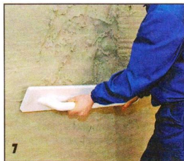
7 Закончить выравнивание раствора нужно до того, как он схватится. Для этой работы используют полутёрки.
