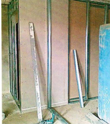
Начинают монтаж каркаса с монтажа профилей на потолке, полу и стенах.
